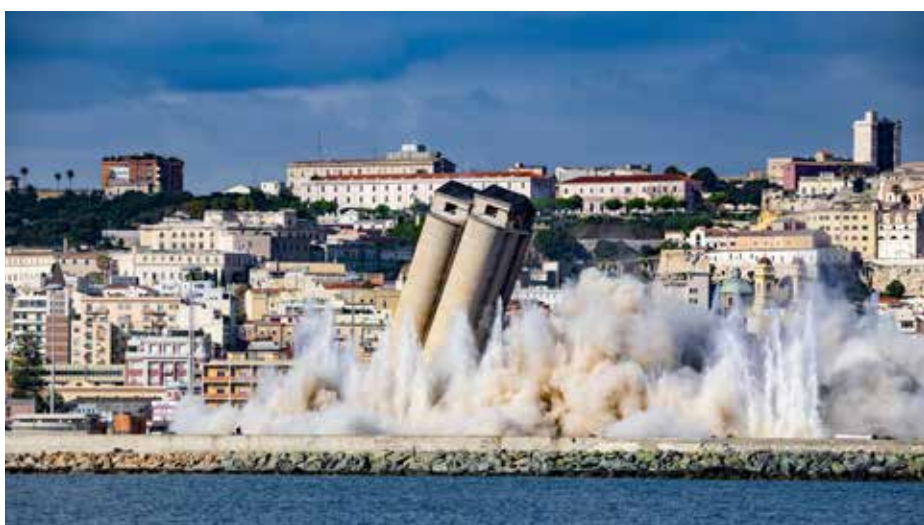
IL CROLLO DEGLI ULTIMI SILOS
