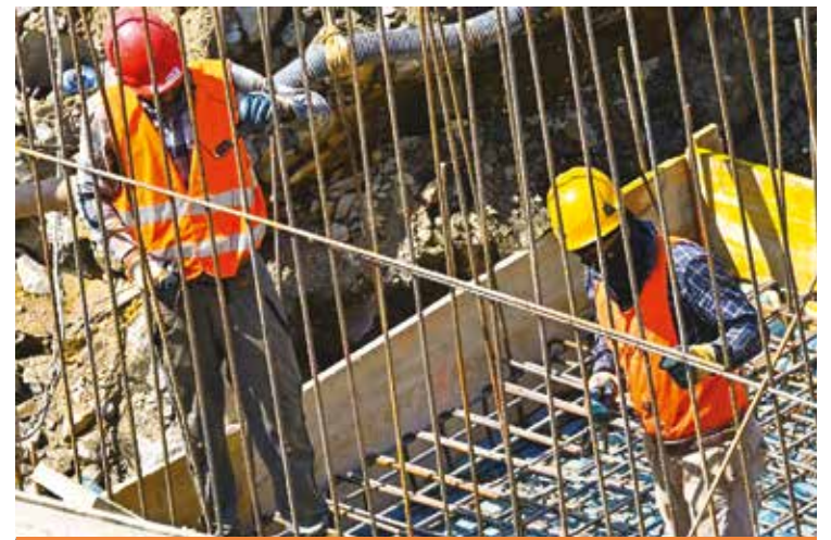
OPERAI IN UN CANTIERE (FOTO VATICAN MEDIA)
